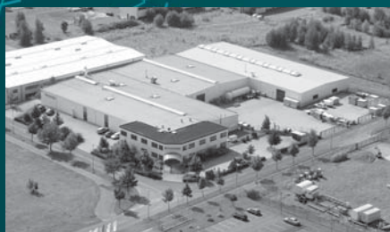
BOSECKER VERTEILERBAU SACHSEN GMBH, ZITTAU
